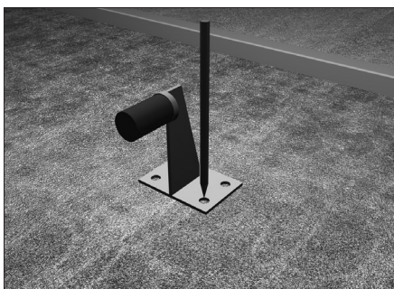
Разметьте место для бокового упора.
