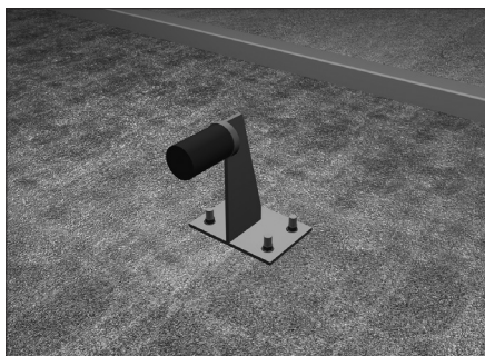
На анкерные болты наденьте основание корпуса бокового упора.
