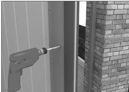
Просверлите 2 отверстия \varnothing 12 в створке.
